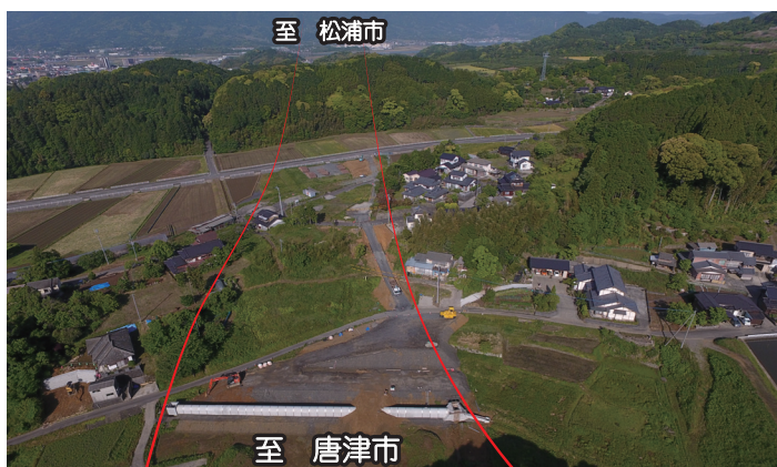
⑤ 脇田地区より 改良工事
