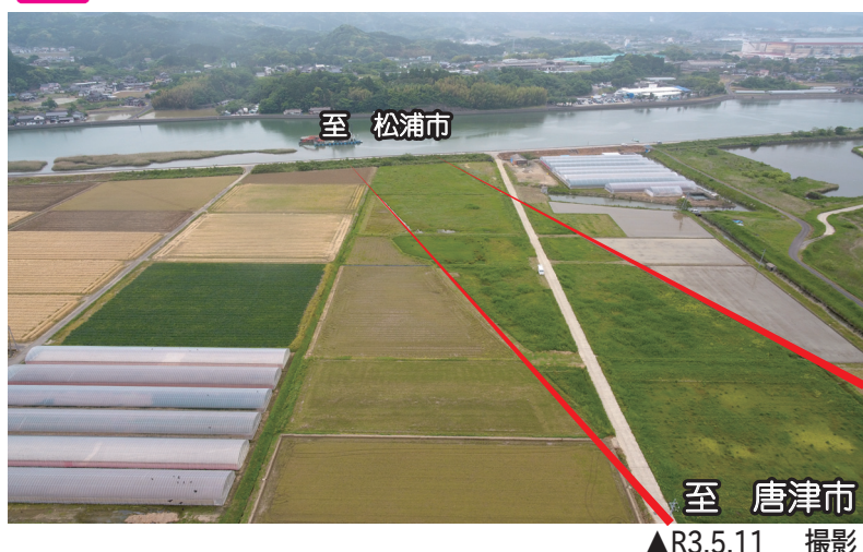
⑧ 二里地区より 地盤改良工事(準備中)
