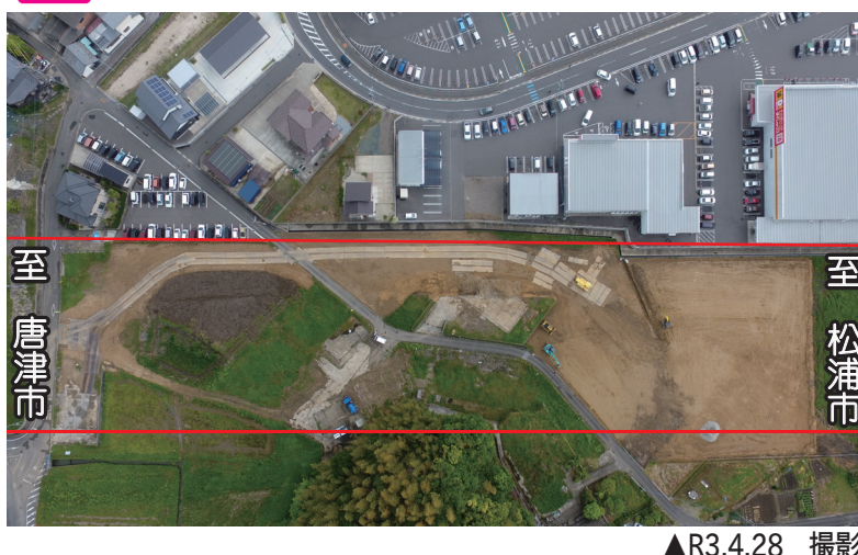
⑦ 木須地区より 地盤改良工事
