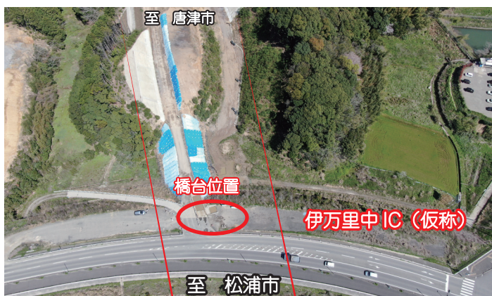
⑥ 木須地区より 橋台工事(準備中)
