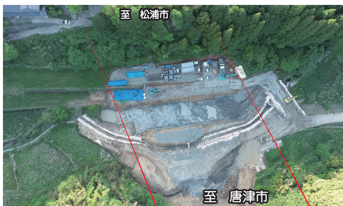
③ 大坪地区より 函渠工事
