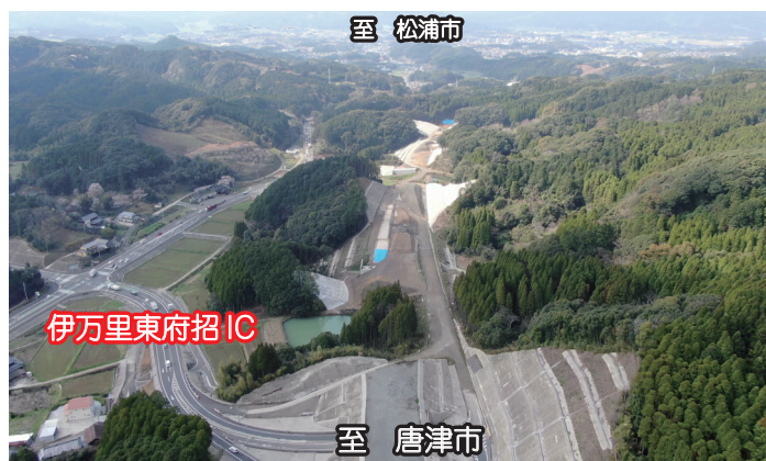
① 南波多地区より 改良工事(準備中)
