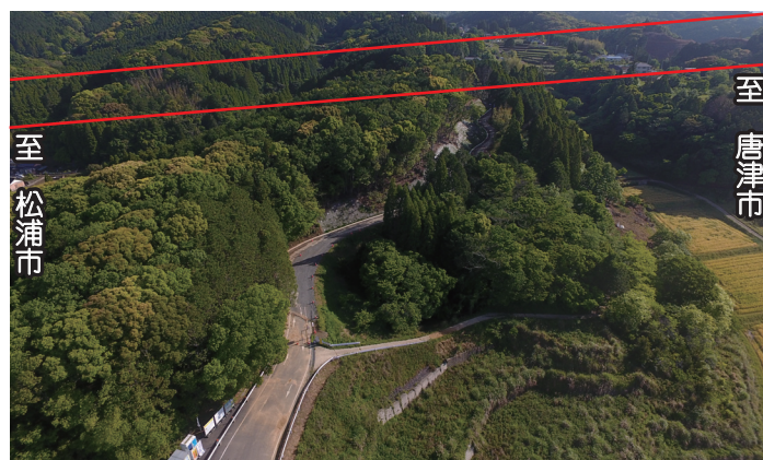
④ 大坪地区より 工事用道路設置工事
