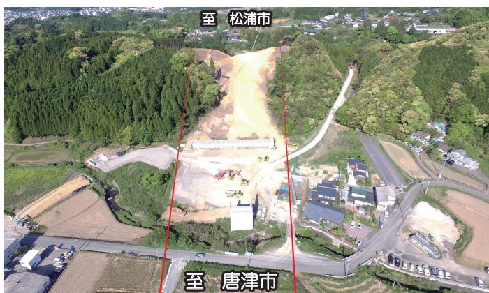
② 大坪地区より 掘削工事
