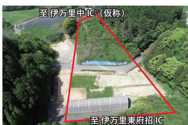
立木伐採施工中
