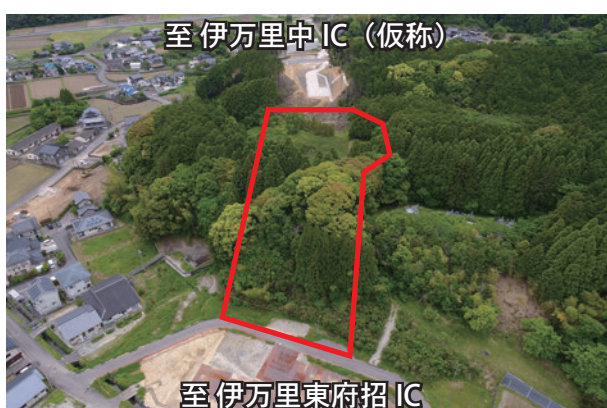
立木伐採施工中
