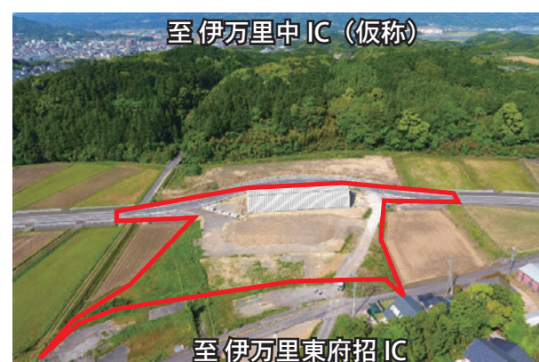
着工準備・測量中
