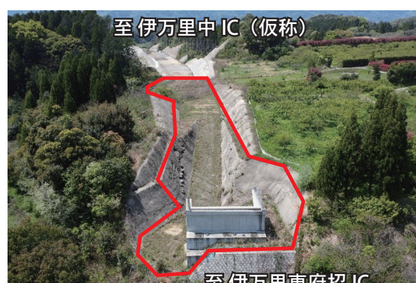
着工準備・測量中
