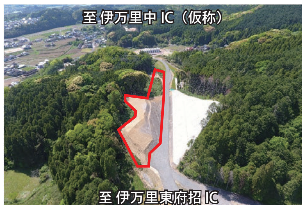
着工準備・測量中
