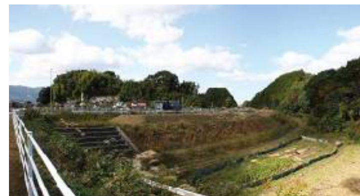
▲現地状況②（伊万里中 IC 予定地）【写真②】
