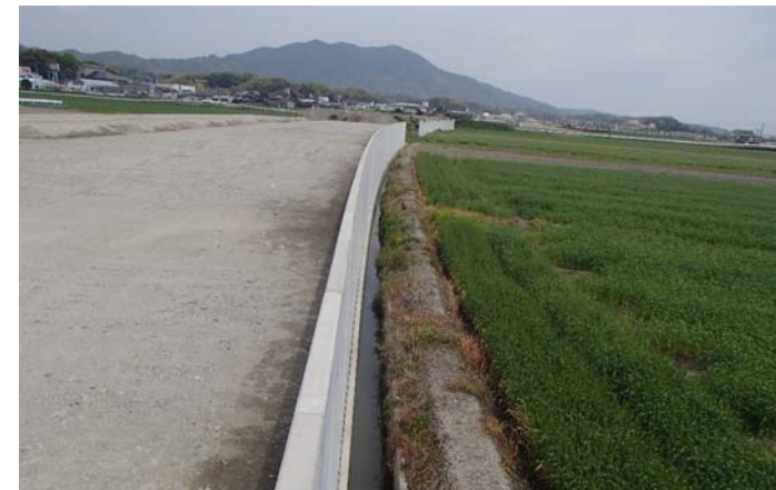
▲整備状況（大崎地区）【写真②】
