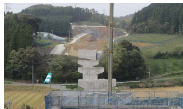
▲整備状況②（板治川橋）【写真②】
