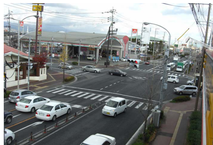
▲現況（佐賀地区電線共同溝）【写真①】
