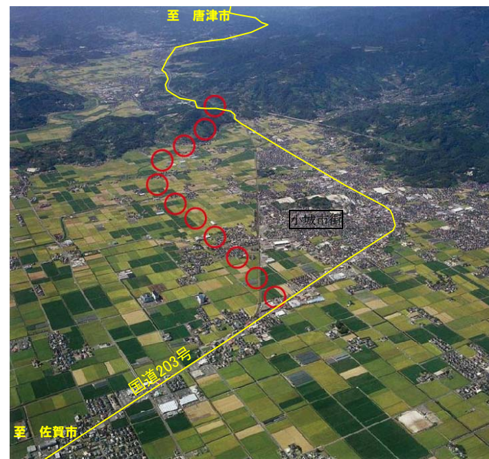
▲多久佐賀道路（Ⅰ期）【写真①】
