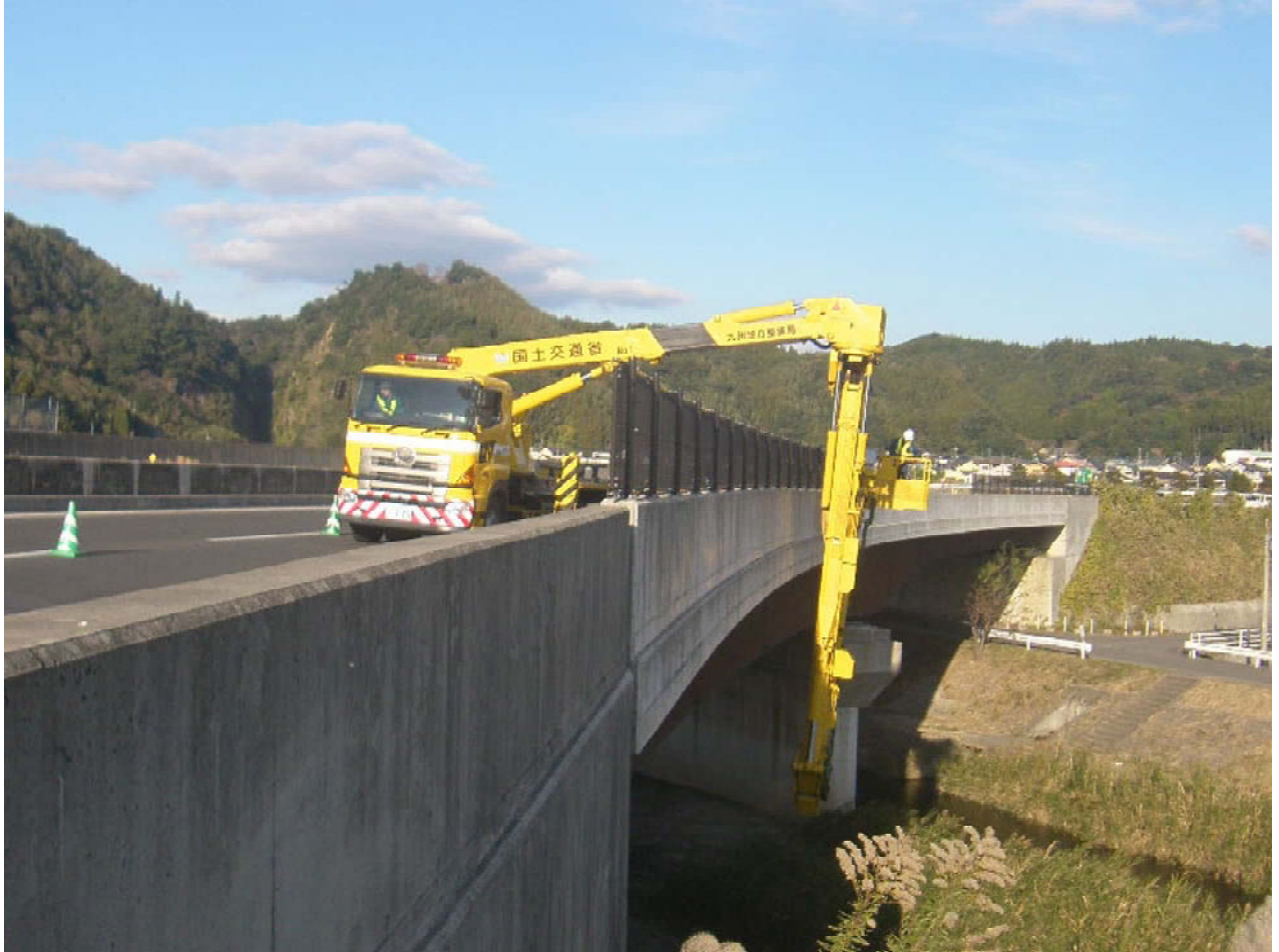
橋梁点検車による近接状況調査作業状況
