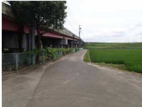
【第1駐車場の側道】
