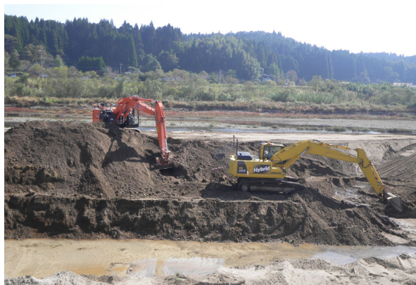
河道掘削の施工状況（羽月川）
