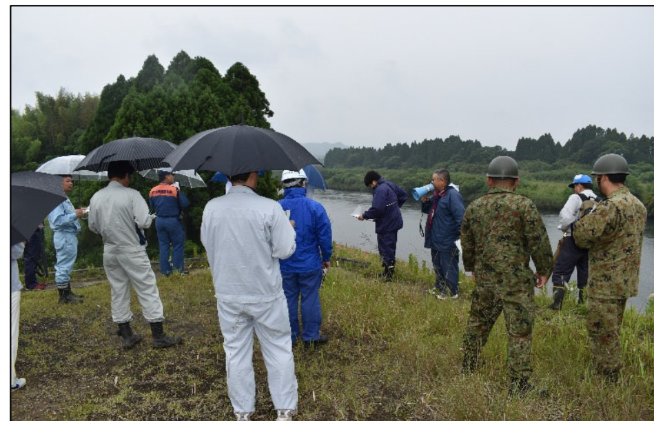
② 現地での重要水防箇所の確認
