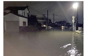
令和2年7月出水による浸水状況
