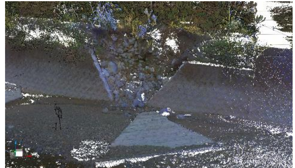
令和2年7月豪雨での災害現場の点群データ
