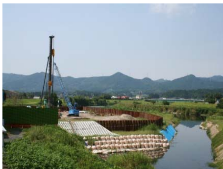
付替水路、鋼矢板縮切り、杭打ち状況
