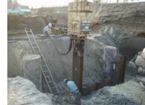
遮水(綱)矢板打設状況
