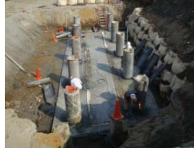
基礎杭打設後状況
