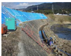
坂元地区（施工中）
