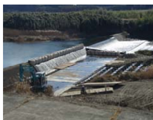
今西床固（施工中）
