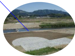
かいだん 階段・ステージ（既設）
