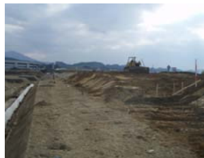
ちくてい もりど 築堤（盛土）
