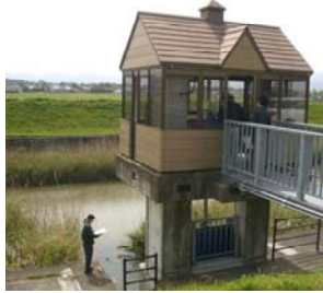
樋門を点検中
