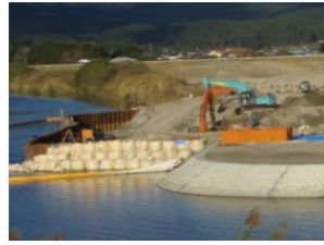
護岸工事中（川内川）
