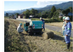
現場点検の様子
