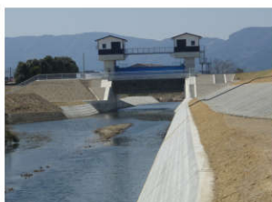
西境川上流より水門を望む
