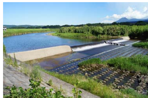
●現在の今西床固の現状写真
