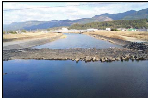
●加久藤橋から下流を見た現状写真
