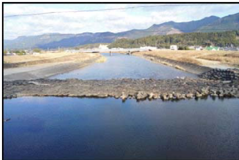
●工事前 (H24年9月)
