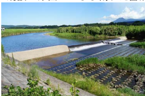
●工事前 (H24年9月)
