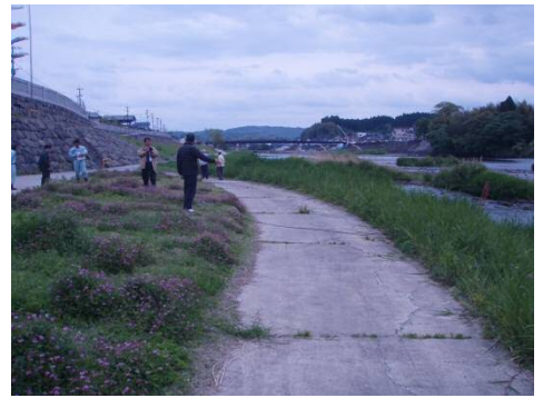
虎居地区での点検状況
