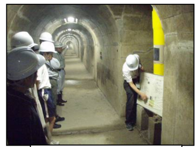
鶴田ダム堤体内
