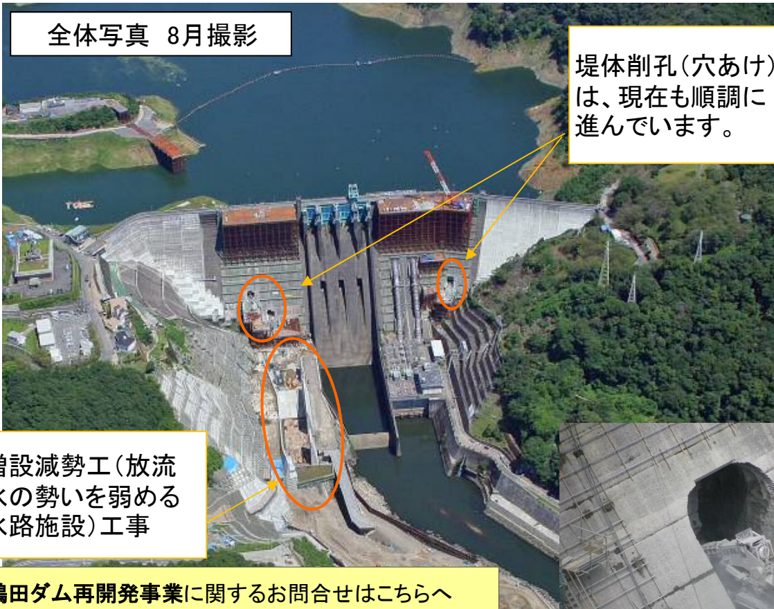
堤体削孔（孔あけ）状況
