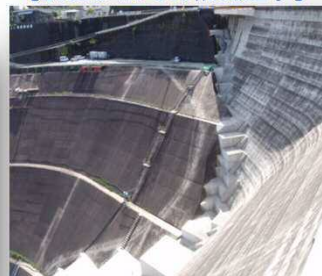
【鶴田ダムでの補強工事】
