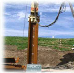
【矢板打込状況】
