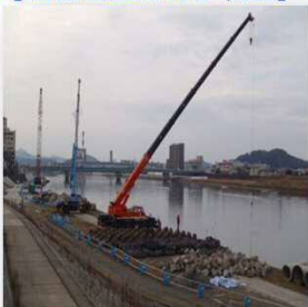
【向田地区での水制工】
