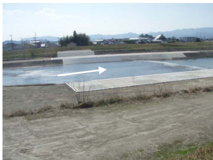
加久藤第四床固（加久藤橋下流）
