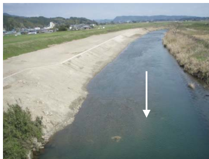
大明司地区（池島大橋上流）
