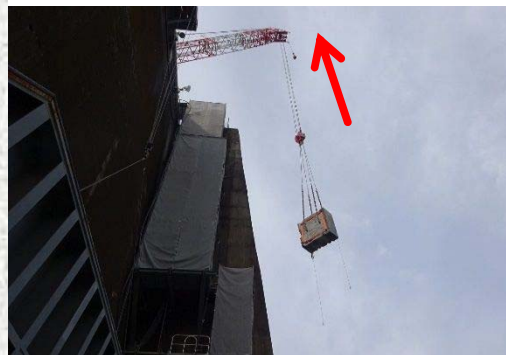
ダム堤体上へ運び出す
