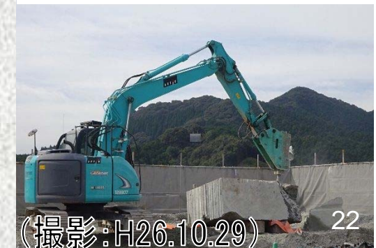
ブレーカー(削岩機)を使って破碎
