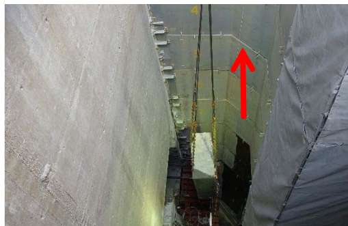
クレーンで吊り上げる
