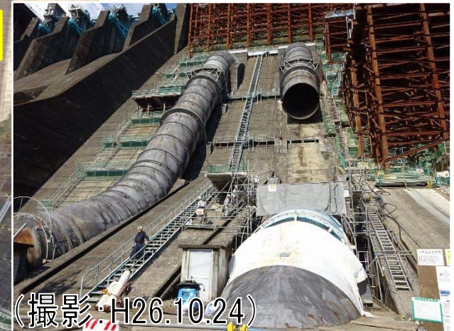
既設発電管撤去後の様子
