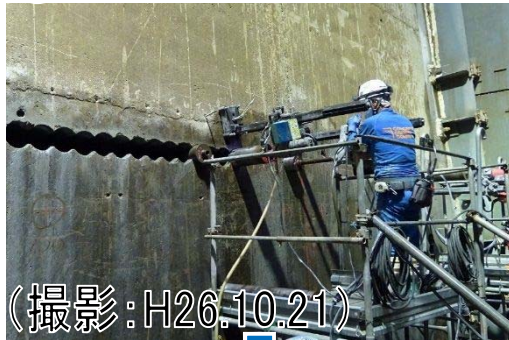
(仮締切内)コア抜きの様子
