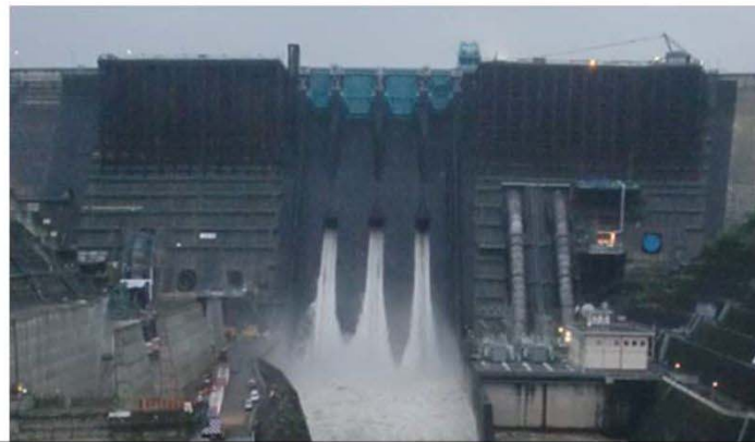
7月7日6時頃の鶴田ダムの状況
