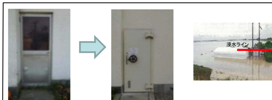
出入口扉の水密化
