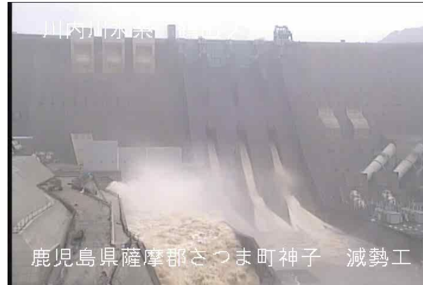
6門によるゲート放流状況（20日15時頃）
