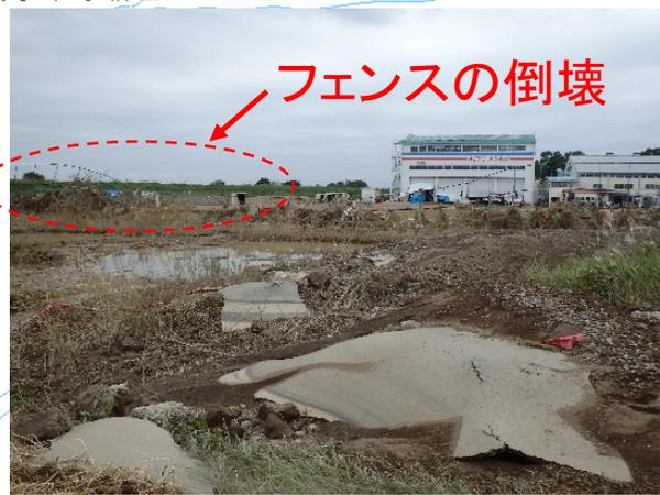
④フェンスの堤内地側への倒壊
