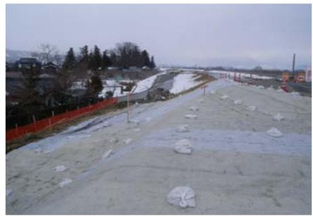
図-4 吸出防止材(縁切)設置状況(2008.3撮影)
