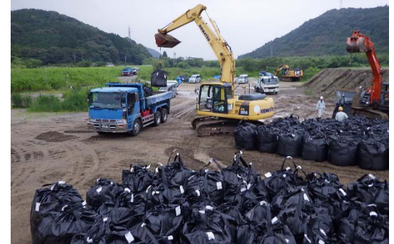
【薩摩川内市】隈之城川県管理区間の応急復旧のため 国保有の大型土のう袋を提供(R2.7月)
