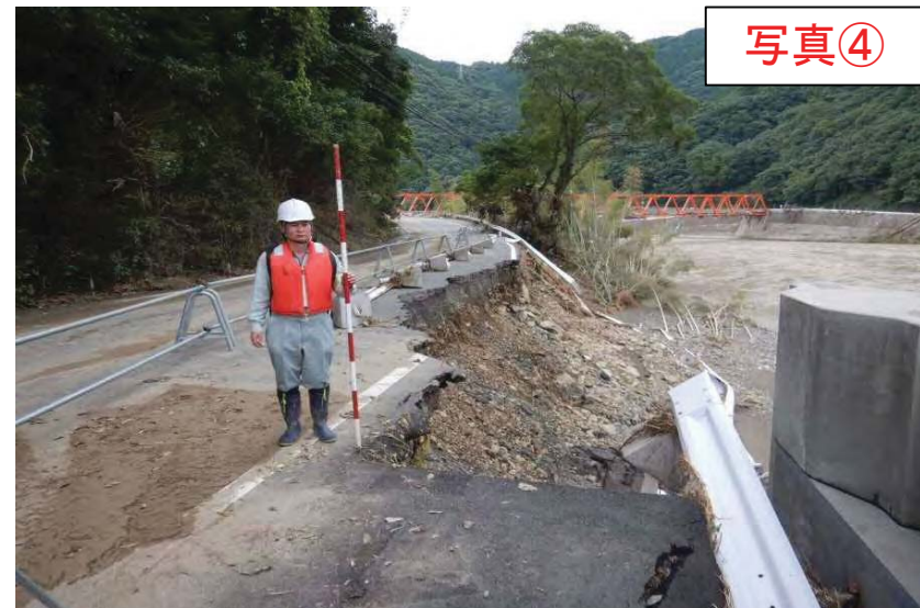
洪水流により被災した国道219号
