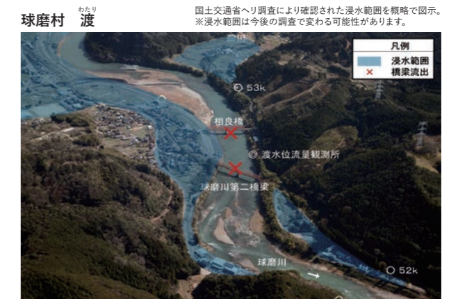
図6 球磨村渡地区の浸水状況
