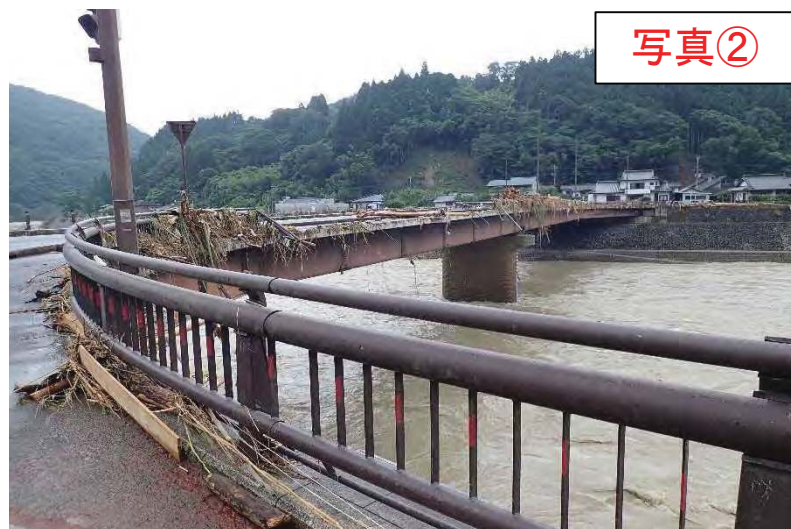
洪水流が橋を乗り越え、高欄が欠損した球磨橋
