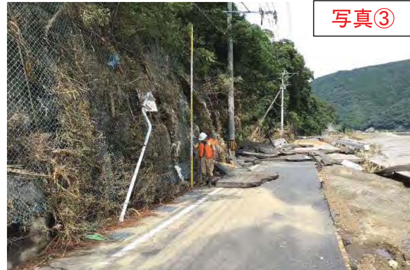
洪水流により被災した国道219号
