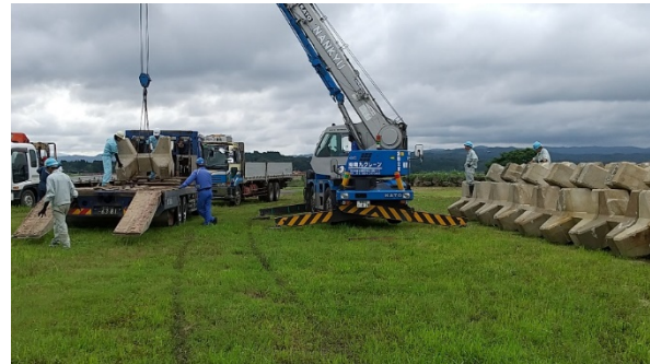
【伊佐市】羽月川県管理区間の応急復旧のため 国保有の根固めブロックを提供(R2.7月)
