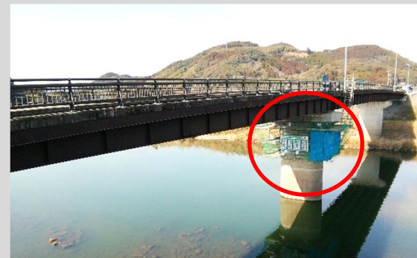
山崎橋左岸橋脚 施工中の状況(R6.2.9)
