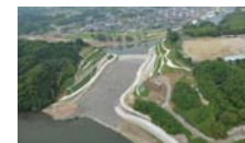
推込分水路工事
