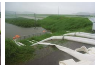
稼働中のポンプ車（下手排水樋門）
