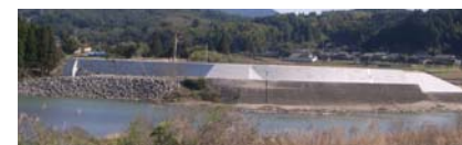
荒瀬地区嵩上げ工事
