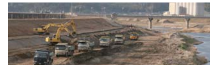
菱刈地区掘削工事
