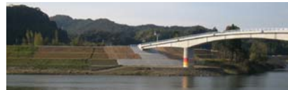
久住地区橋梁工事(薩摩川内市事業)
