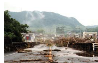
流木が折り重なる宮都大橋
