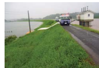
稼働中のポンプ車（里樋門）
