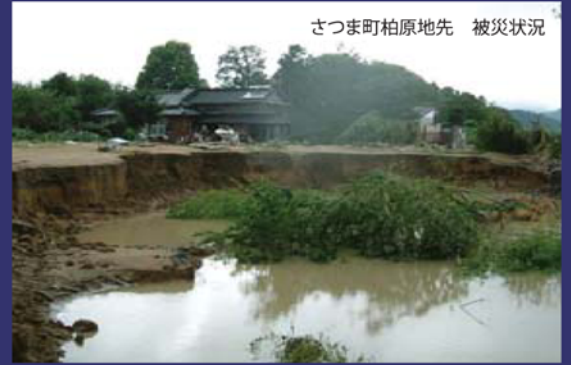
薩摩川内市南瀬下地先 被災状況
