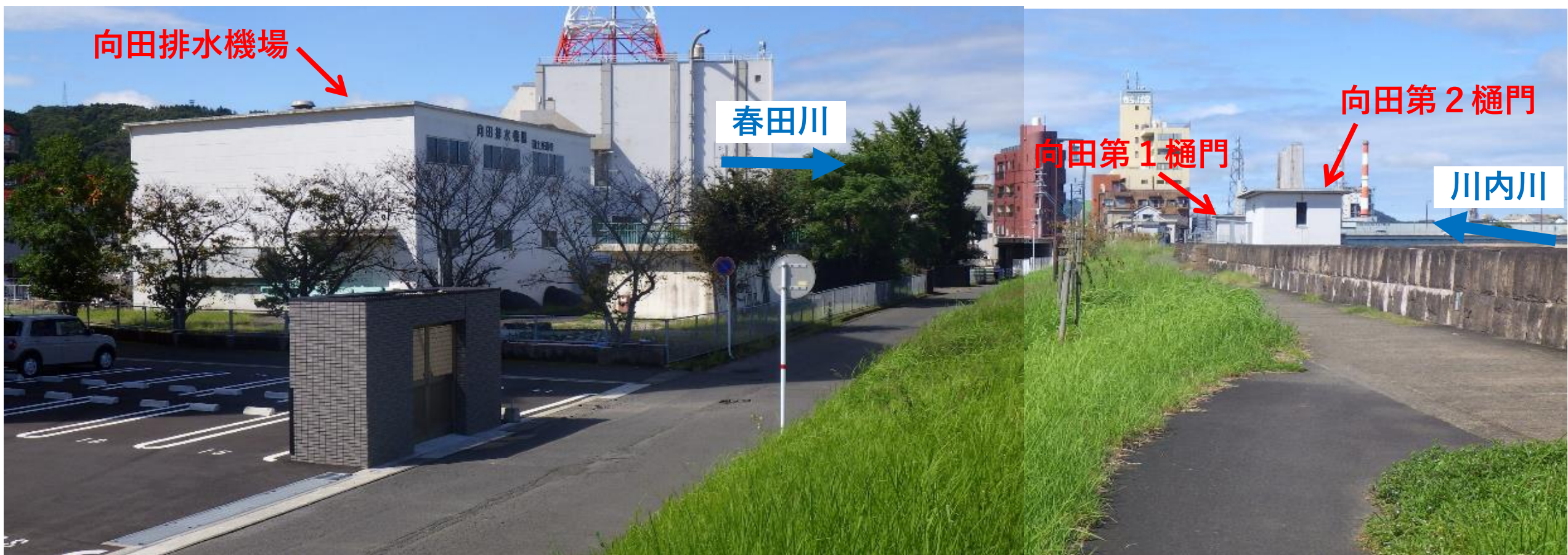
上流側から撮影
