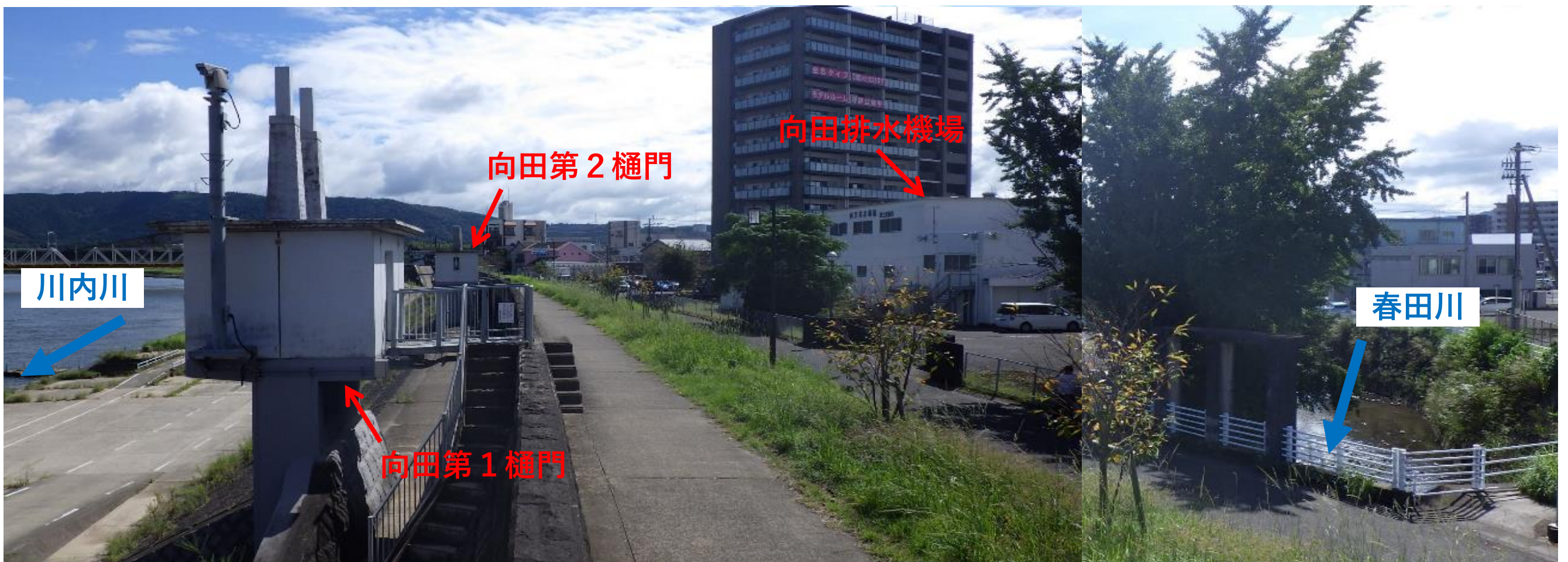
下流側から撮影
