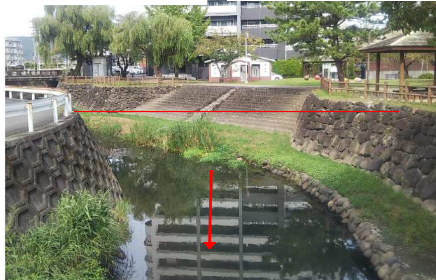
春田川公園付近 (護岸高は調査中)
