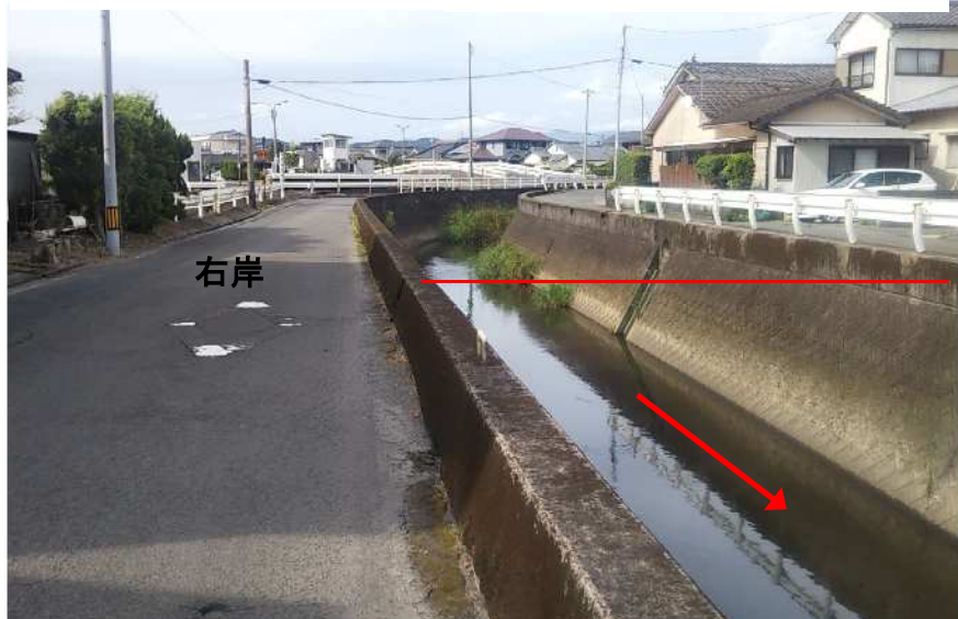
自動車学校付近 (護岸高は調査中)
