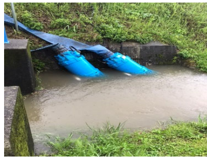
《市》ポンプ設置状況
