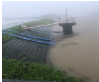
《市》ポンプ排水状況
