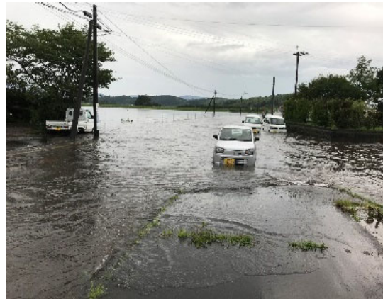
内水氾濫状況
