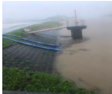
＜市＞ポンプ排水状況
