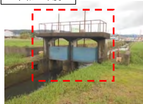
原田井堰の撤去 (R5)
