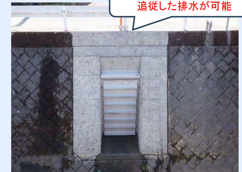
【吐出口】多段式フラップゲートの設置
