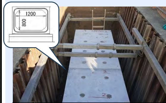
放水路整備 (施工中)
