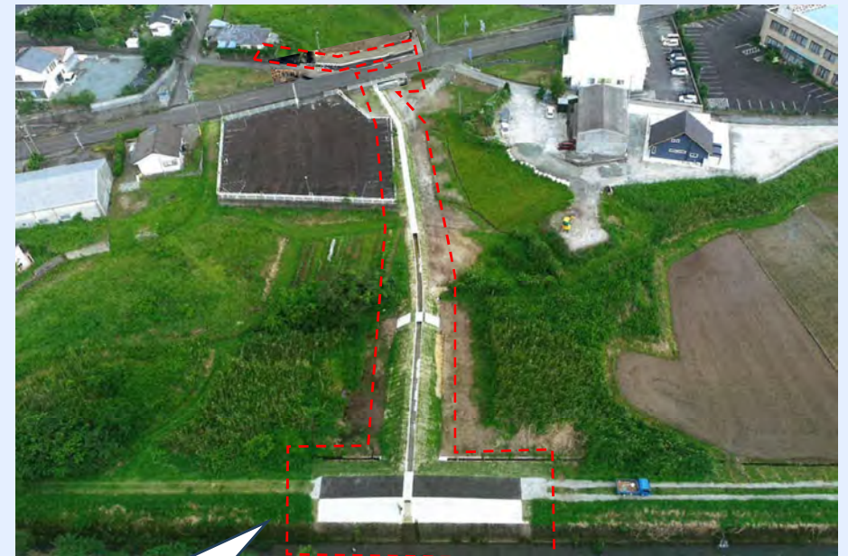
排水路整備完了
