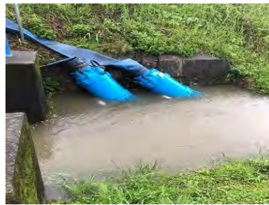
＜市＞ポンプ設置状況
