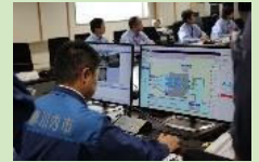
向田排水機場の遠隔操作 (薩摩川内市)
