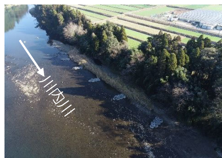
水制工設置状況
