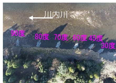
水制工設置状況
