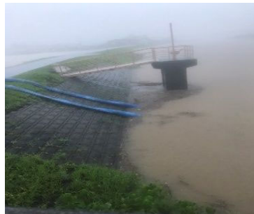
＜＜市＞＞ポンプ排水状況
