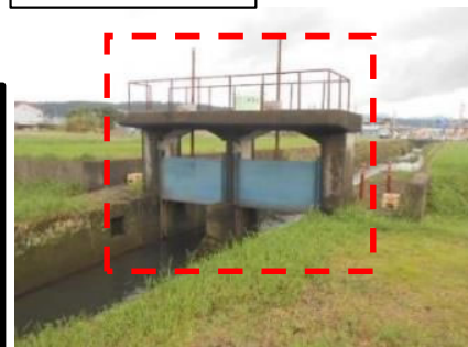
原田井堰の撤去 (R5)
