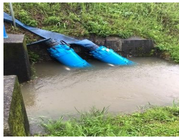
＜＜市＞＞ポンプ設置状況
