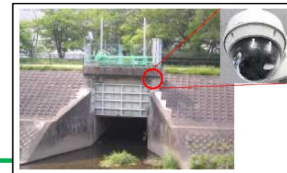
360°カメラの設置
