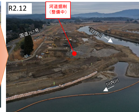
整備中(令和2年12月時点)【継続中】
