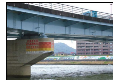
橋梁への危険度レベルの表示
