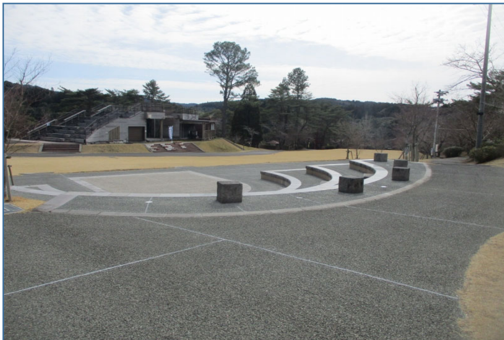
曾木の滝公園 園路の透水性舗装
