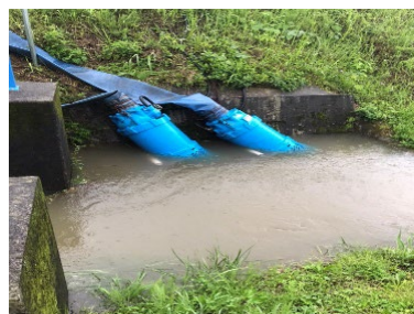
《市》ポンプ設置状況
