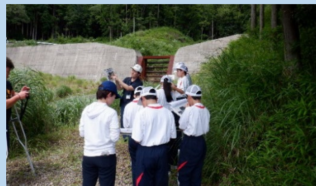
砂防堰堤の見学
