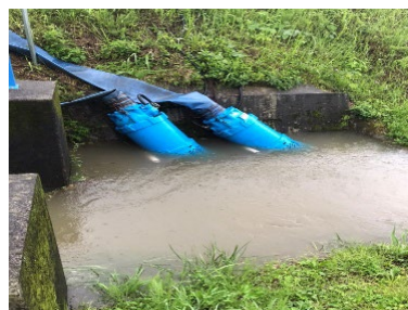
《市》ポンプ設置状況
