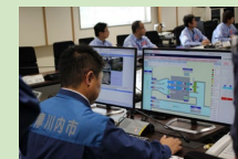
向田排水機場の遠隔操作 (薩摩川内市)
