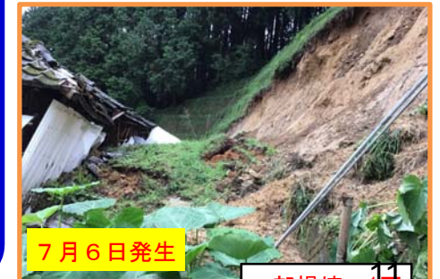
がけ崩れ 宮崎県串間市松頭
