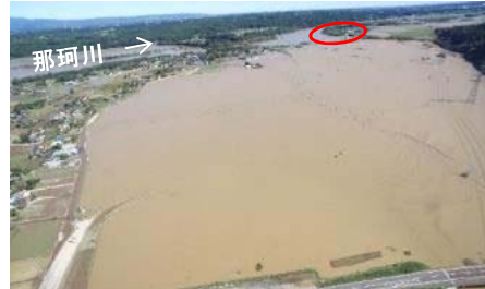
写真② 浸水被害状況（茨城県那珂市、城里町）
