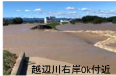
越辺川右岸0k付近
