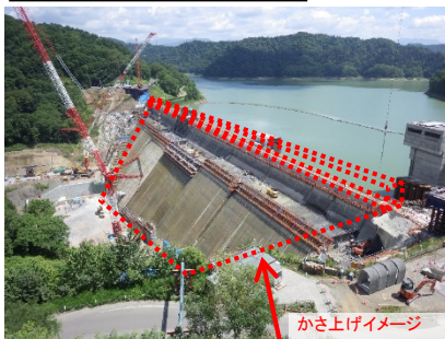
ダム建設・ダム再生
