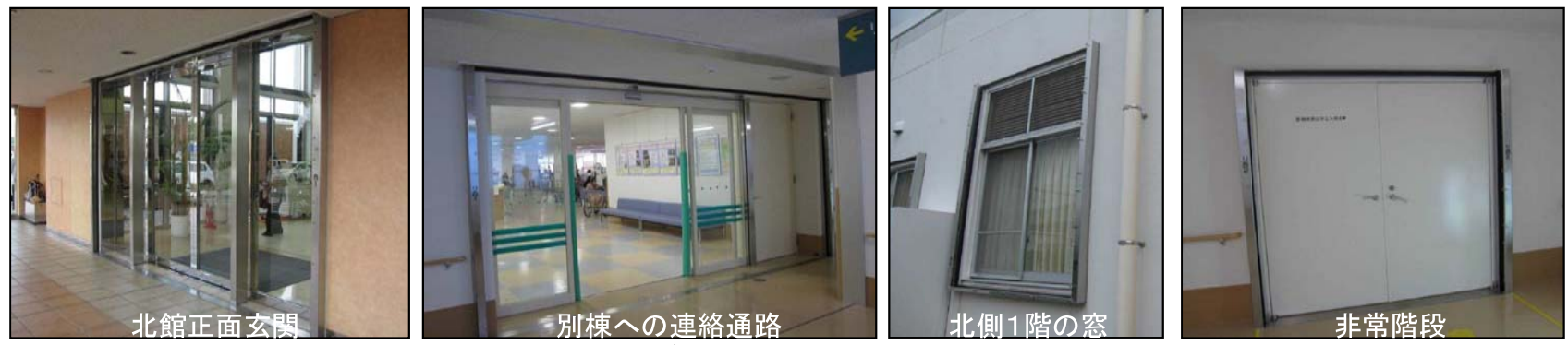
止水板のための角落としの設置
