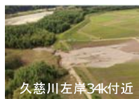
久慈川左岸34km付近
