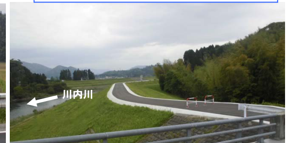
久住地区施工状況
