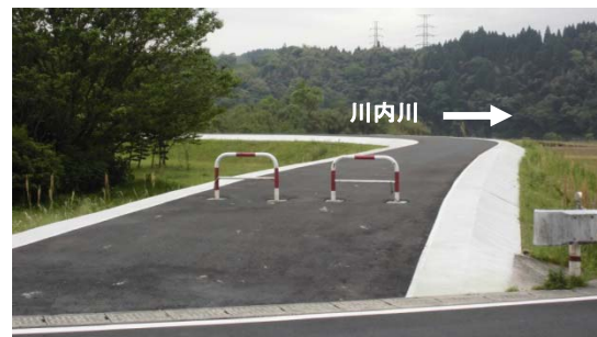
南瀬下地区施工状況
