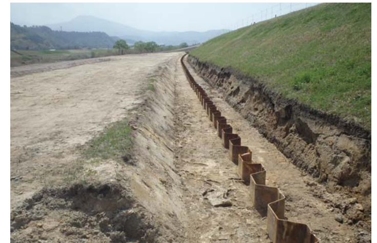
矢板打設施工状況(吉松橋上流左岸付近)
