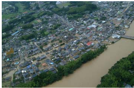
川内川 37k100付近より上流右岸を望む さつま町虎居地区
