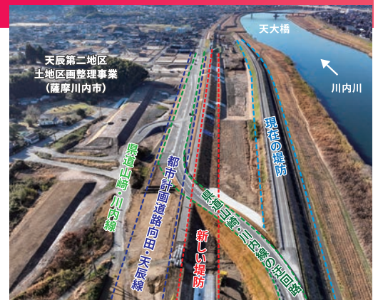
天辰第二地区(工事中)
