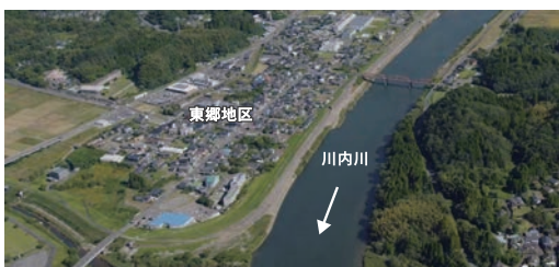
東郷地区(工事中)
