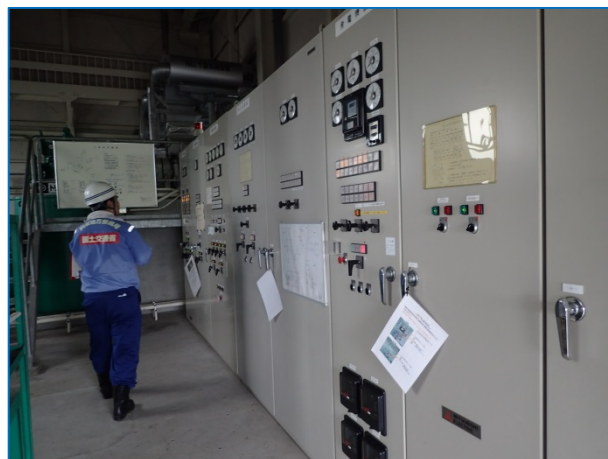
三条排水機場 操作盤調査 (芦刈町)
