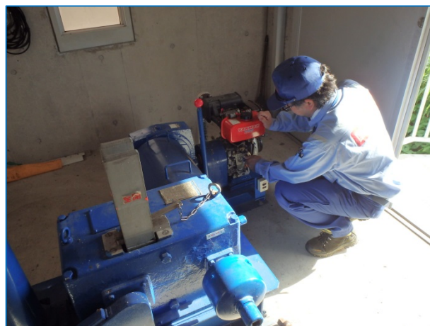
納手分水樋管 開閉装置調査 (武雄市)
