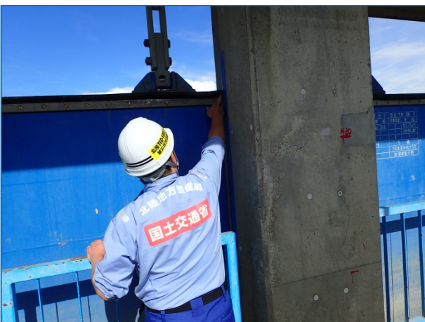
満神排水樋管 扉体調査 (小城市)
