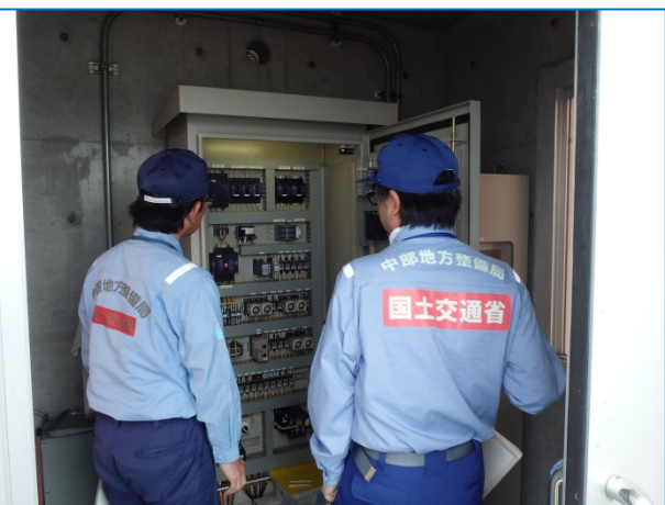
北搦排水樋管 機側操作盤調査 (白石町)
