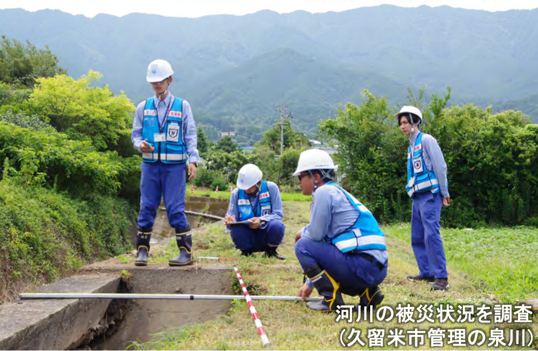
河川の被災状況を調査 (久留米市管理の七夕川)
