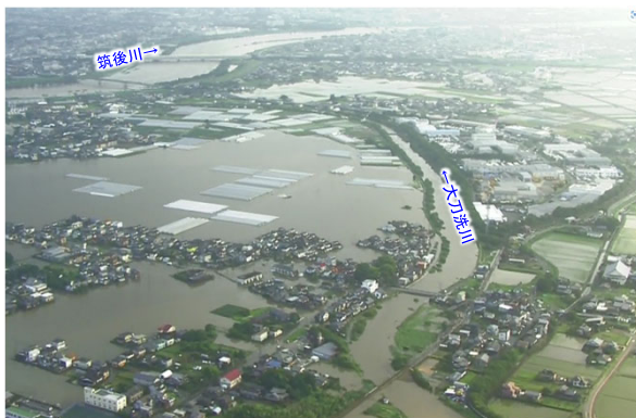
筑後川水系における浸水被災状況調査 (はるかぜ号による浸水上空調査)
